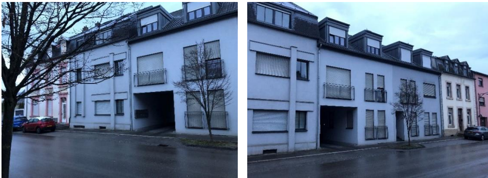
Photo 1 et 2 : Vue sur les immeubles situés sur la « route d'Echternach » - n° 11 et 13 (à gauche) – n°13A et 15 (à droite) (Source : BEST)
