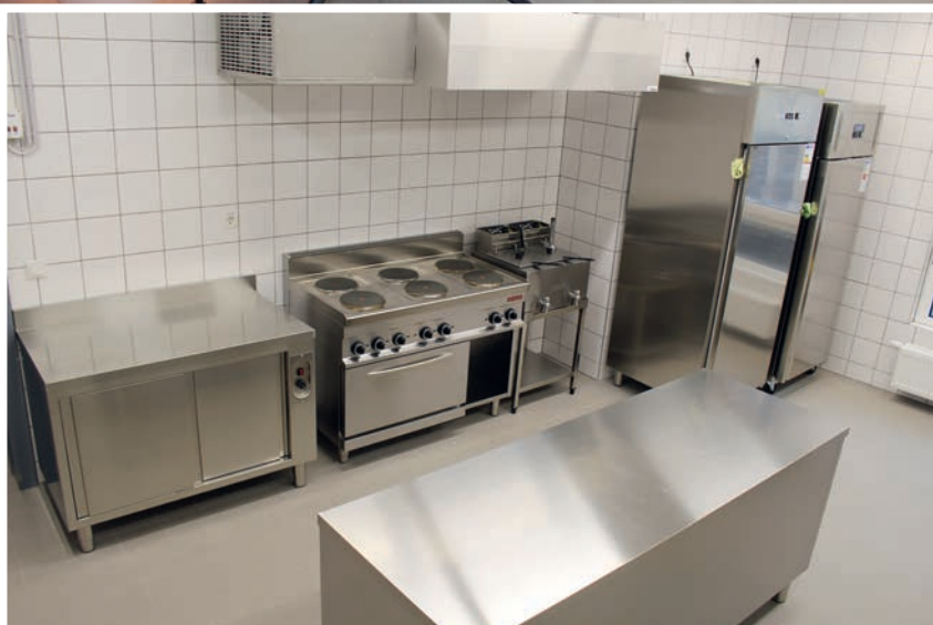
Mertert: Im Kulturzentrum wurde eine professionelle Küche installiert Une cuisine professionnelle a été installée dans le centre culturel
