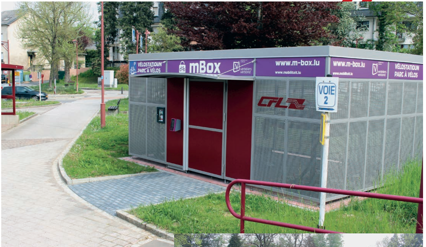
Eine Mbox für Mertert / Une mbox pour Mertert
