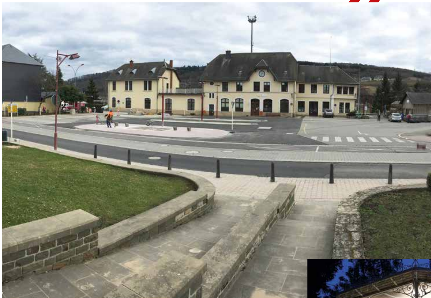
Die Bus-Station vor dem Bahnhof in Wasserbillig vor der Fertigstellung La gare routière devant la gare de Wasserbillig en finalisation
