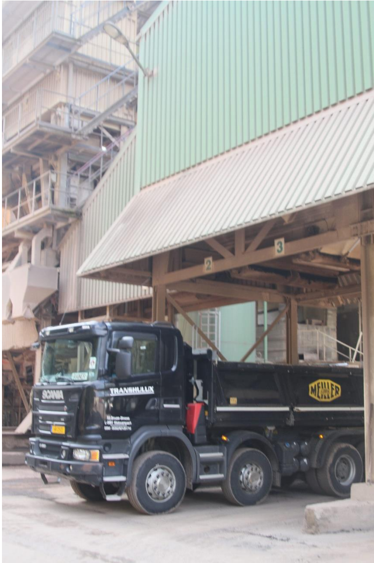
Abbildung 33: LKW unter dem Verladesilo
