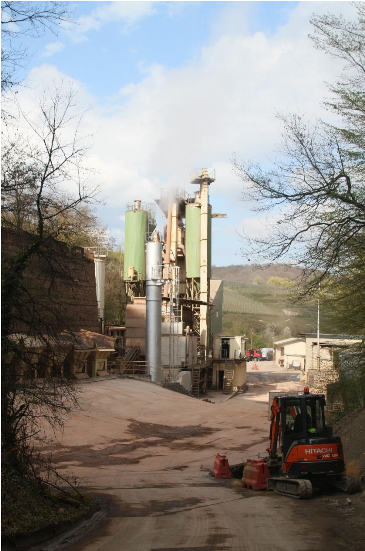
Abbildung 32: Asphaltmischanlage von NW
