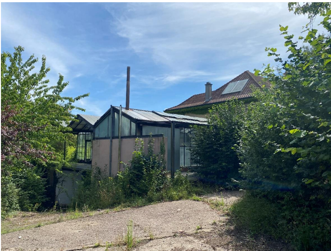
Abbildung 3: Zentraler Bereich des UG mit leerstehendem Wohnhaus
