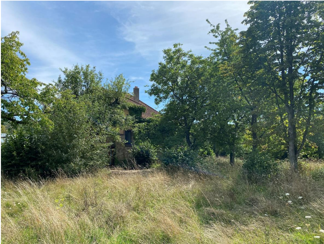
Abbildung 2: Zentraler Bereich des VB mit leerstehendem Wohnhaus und Gehölzen, Blickrichtung von Süden
