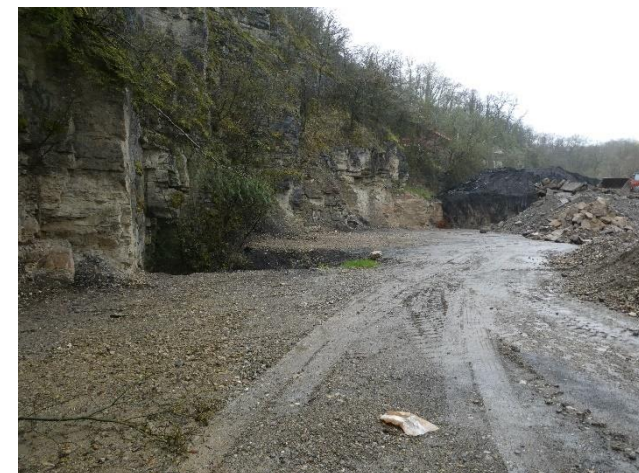
Geräumtes Vorfeld des Stolleneingangs bzw. der Einflugöffnung für Fledermäuse (ProSolut S.A., 04/2023)
