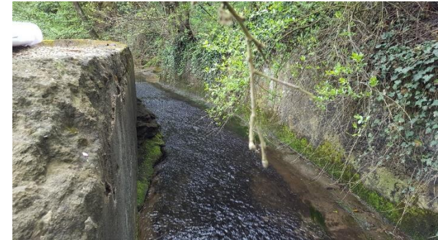
Sernigerbaach, befestigter Abschnitt, im Westen des Plangebietes (Luxplan S.A., 2019)
