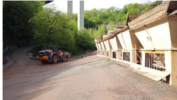
Teil der Mischeranlage (Luxplan S.A., 2019)
