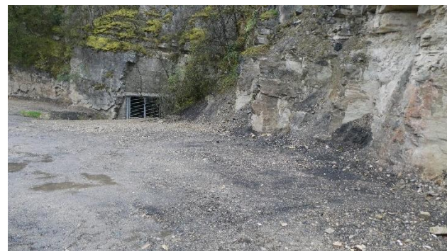
Geräumte Vorflächen zum Stolleneingang mit Einflugöffnung für Fledermäuse (ProSolut S.A., 04/2023)
