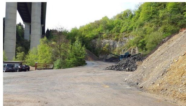
Felswand mit Stolleneingang, globale Ansicht (Luxplan S.A., 2019)
